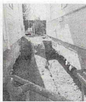
床下の土壌は地盤改良どころか手抜き工事としか考えられない状態だった
