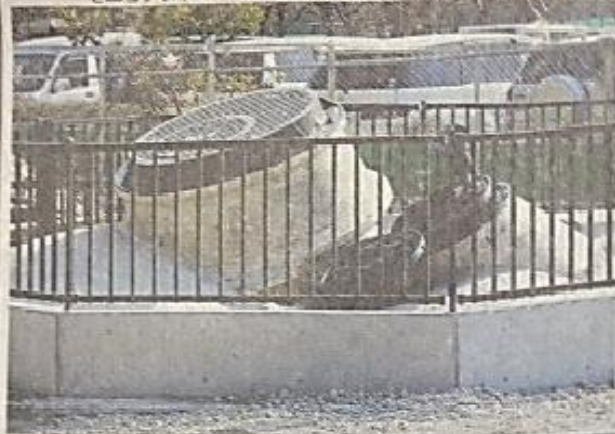
液状化で地中から飛び出したマンホールを保存した震災モニュメント。千葉県浦安市高洲で（村上樹撮影）
